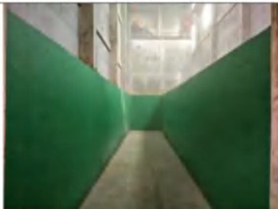
危废储坑防渗
