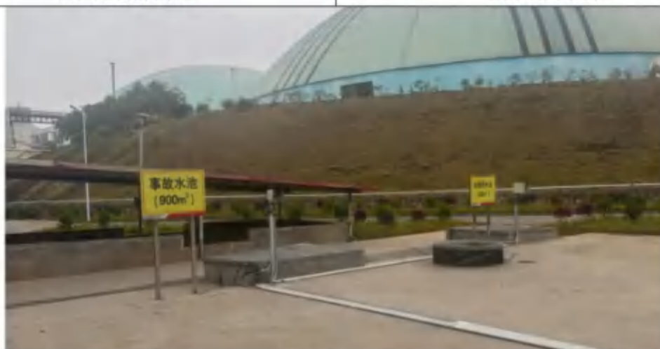
半固态+RDF 预处理车间南侧 900m 3 事故应急池、500m 3 初期雨水池
