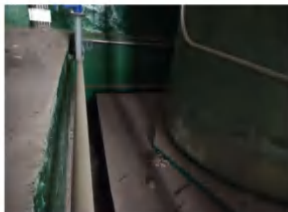
废液储罐围堰
