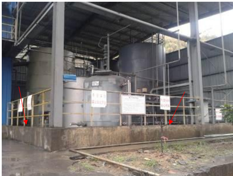
图 5-1 氨水储罐围堰图
