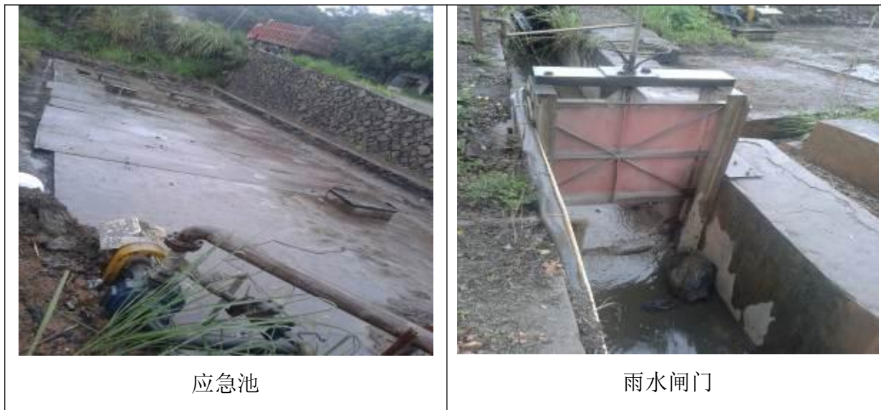
图 5-3 事故应急池及雨水闸门位置图
